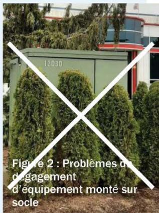
Figure 2 : Problèmes de dégagement d'équipement monté sur socle
