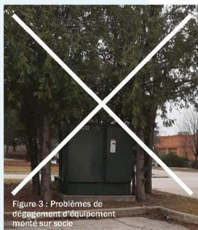
Figure 3 : Problèmes de dégagement d'équipement monté sur socle
